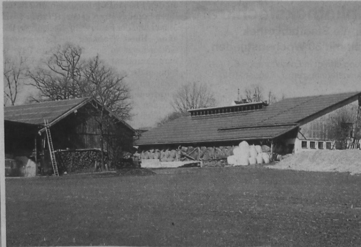
950 Quadratmeter Dachfläche umfasst die erste Fotovoltaikanlage der Dachauer Bürgerstrom-Genossenschaft im Bergkirchener Ortsteil Breitenau: Die Anlage mit einer Leistung von 121,5 Kilowatt soll rund 122 000 Kilowattstunden Strom im Jahr liefern.
